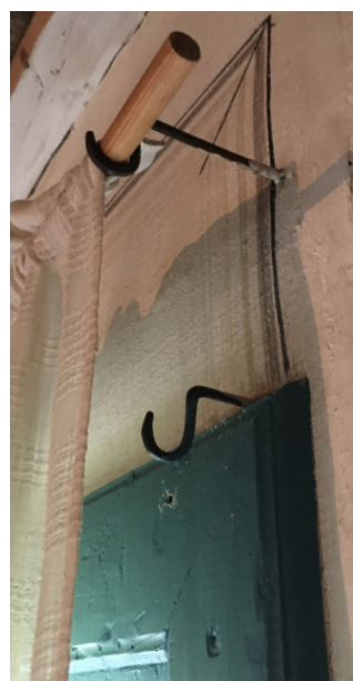
8. Handsmitt fäste. Övre krok för gardin och undre för rullgardin utan draganordning. Mårtensgården i Edsbyn.
